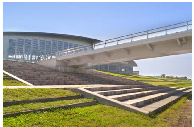
図6 水辺へとみちびく橋詰の大階段
