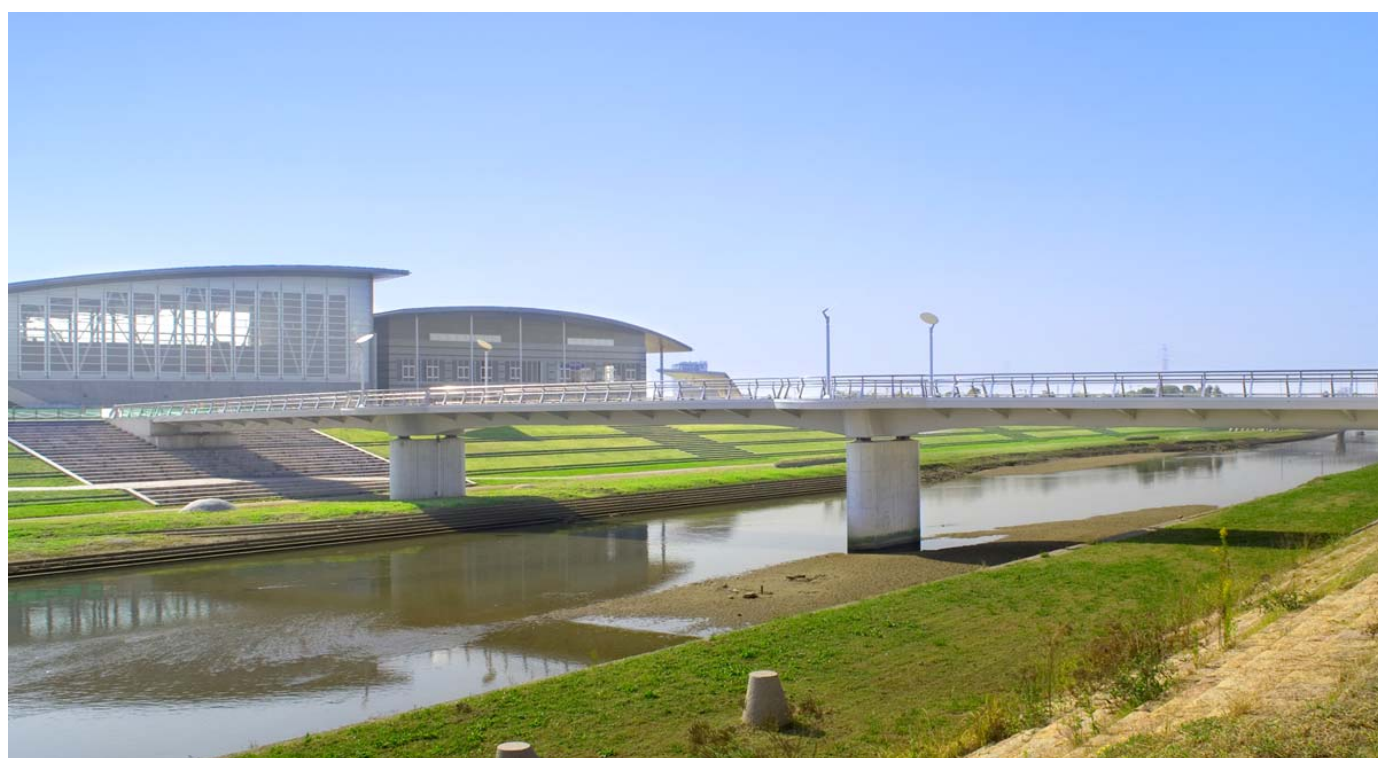
図1 逢妻さくら橋の全景。左手の建物は建設中の体育館。
