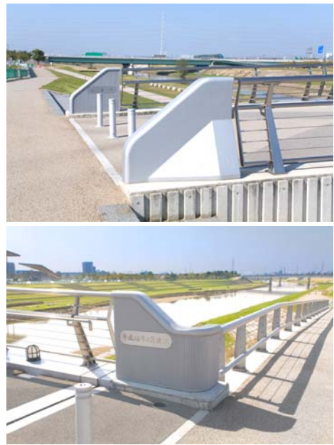
図5 親柱のデザイン（上が左岸部、下が右岸部）
